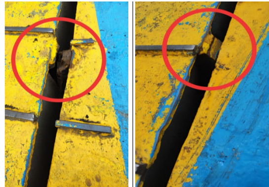
Gambar 3 Keretakan Ramp Door Kapal
